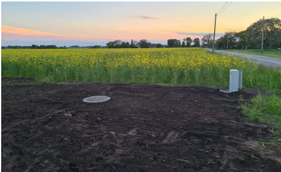
Eksimpel på anlæg – dæksel og styreskab – placeringen vist under
