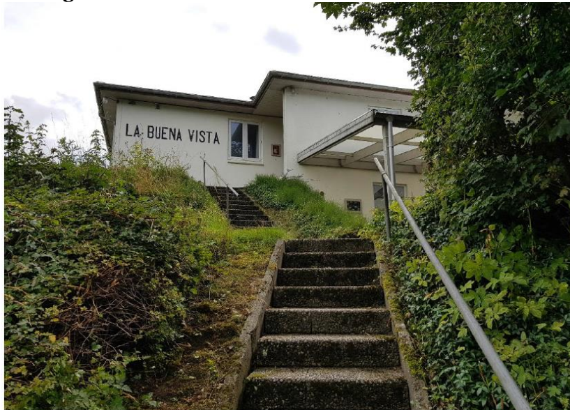
Nordside af hus set ca. 3/4 dele oppe af tappen fra garagen til plateauet til kælderetagen, enst
