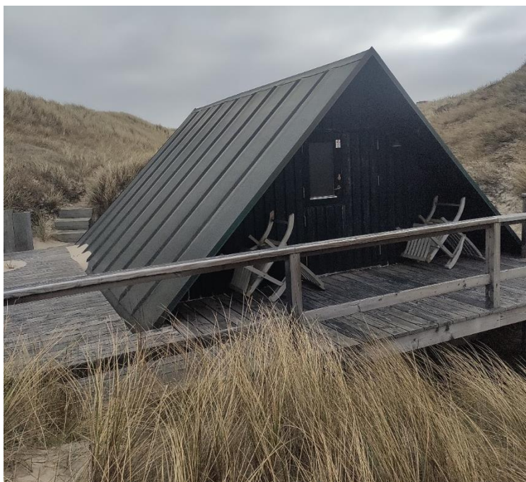
Foto af bygningen set fra terræn indsendt af ansøger.
