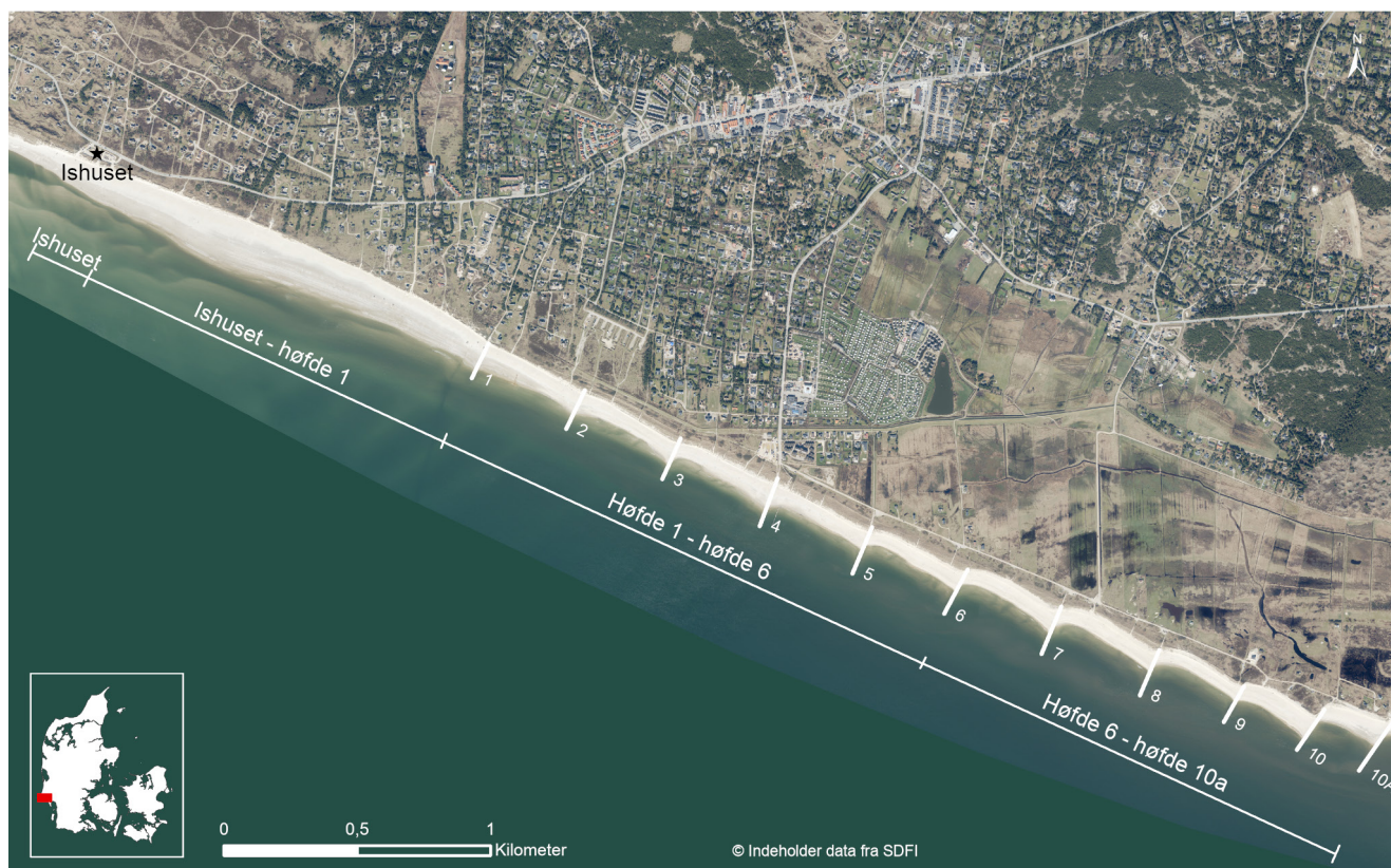
Fig. 1.1 Fællesaftalestrækningen ved Blåvand med delstrækninger
