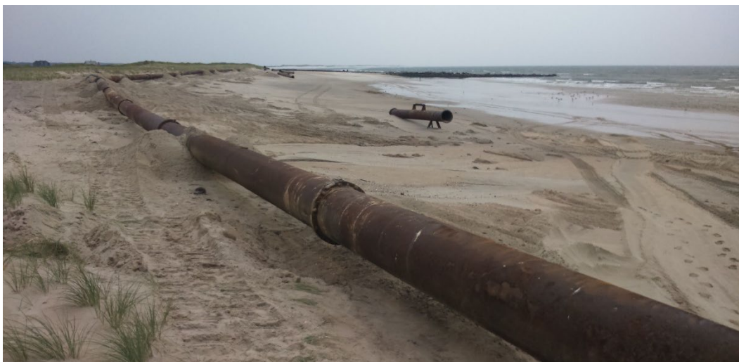
Figur 1-8. Indpumpning med bundliggende rørledning ved Blåvand.
