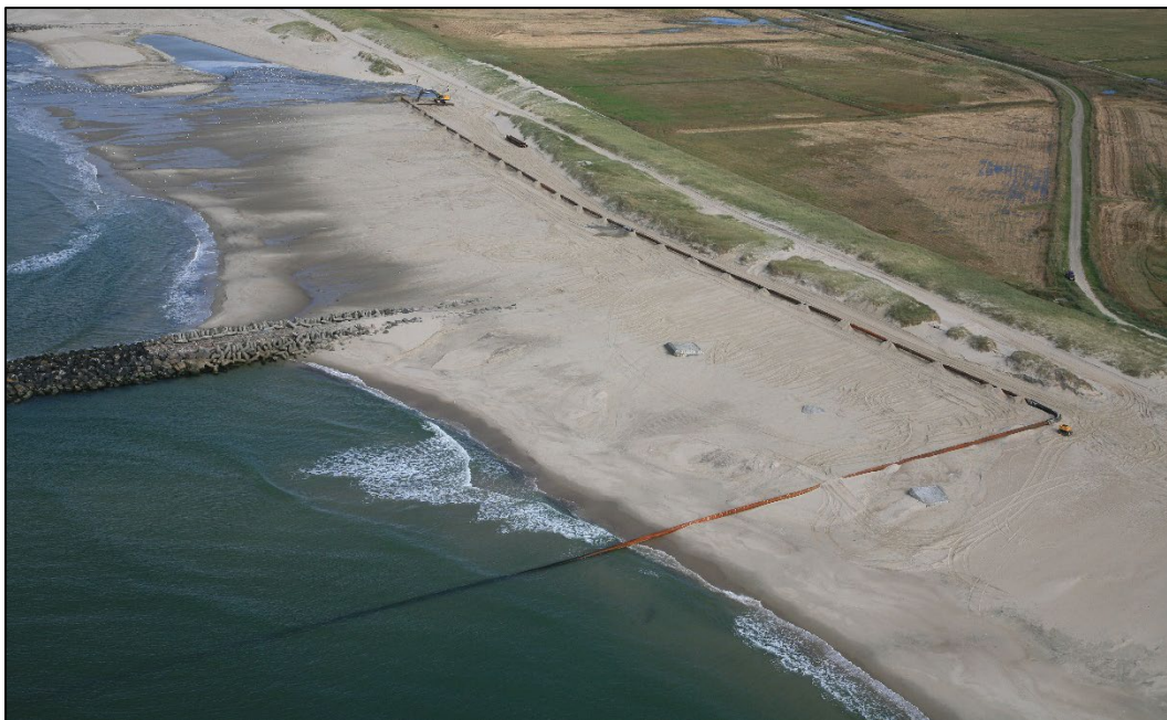
Figur 1-7. Indpumpning med bundliggende rørledning, hvor sandet fordeles parallelt med stranden.
