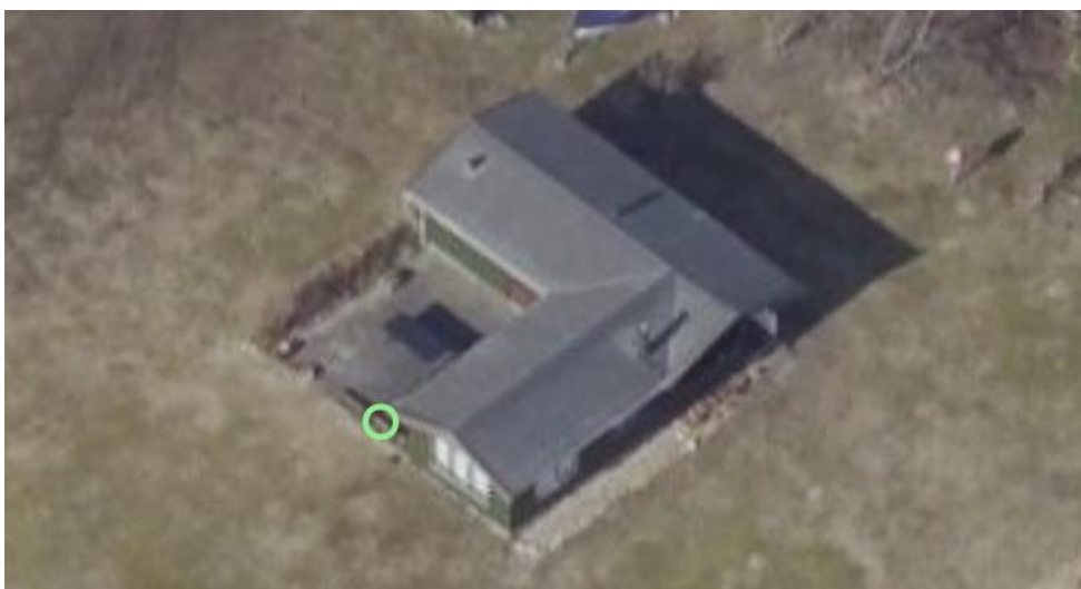
Skråfoto af ejendommen. Den overdækkede terrasse ses til højre på billedet.
