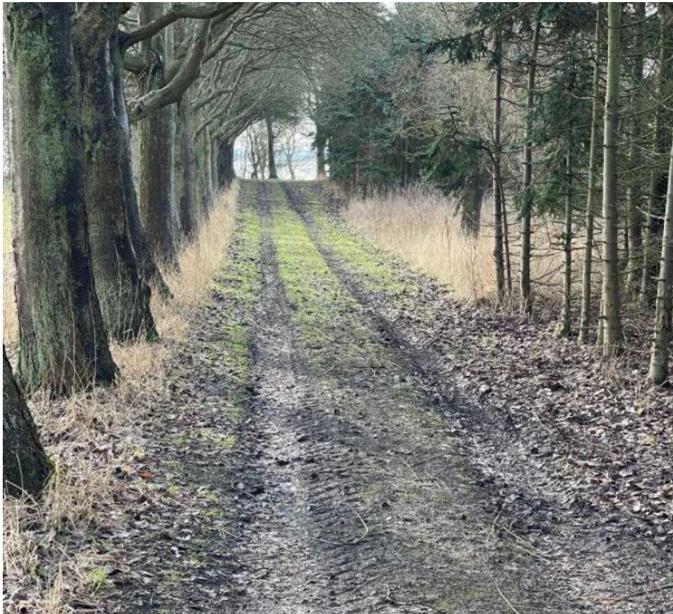
Figur 3, billede af eksisterende vej, fra ansøgning. Vejen skal alene forsynes med toplag i nødsten.
