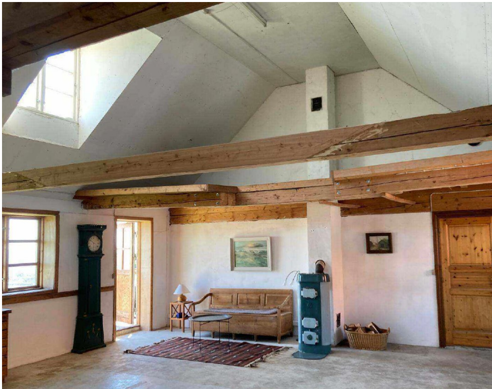
Figur 4, billede fremsendt af ansøger af bygning 3 ind mod stuehuset
