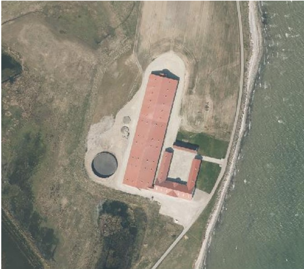
Gyllebeholderen der skal overdækkes
