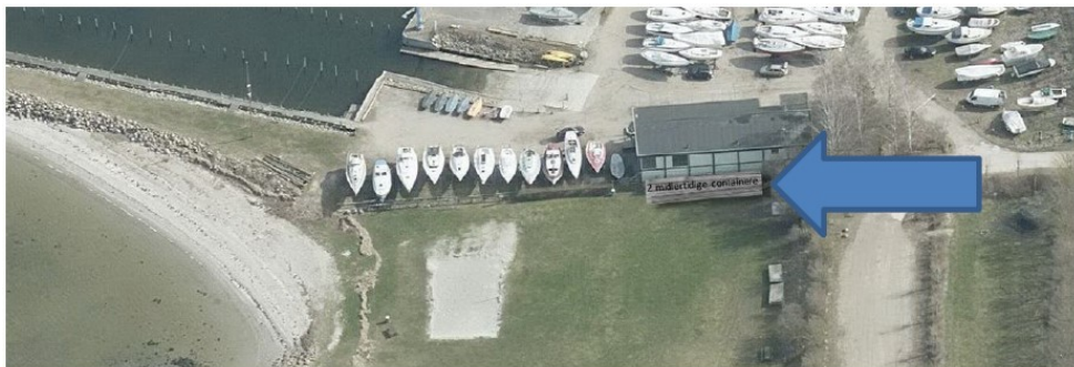
Lejre Kommunes visualisering af grejbanken placeret ved siden af en eksisterende bygning
