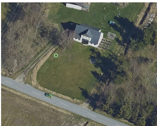
Ejendommen set fra kystsiden
