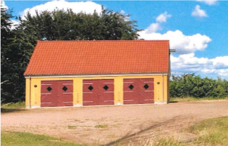
Figur 2, billede af eksisterende forhold – der ses vinduesparti mellem dørene på boligen og tre porte i garage i stedet for de to, der fremgår af tegningerne
