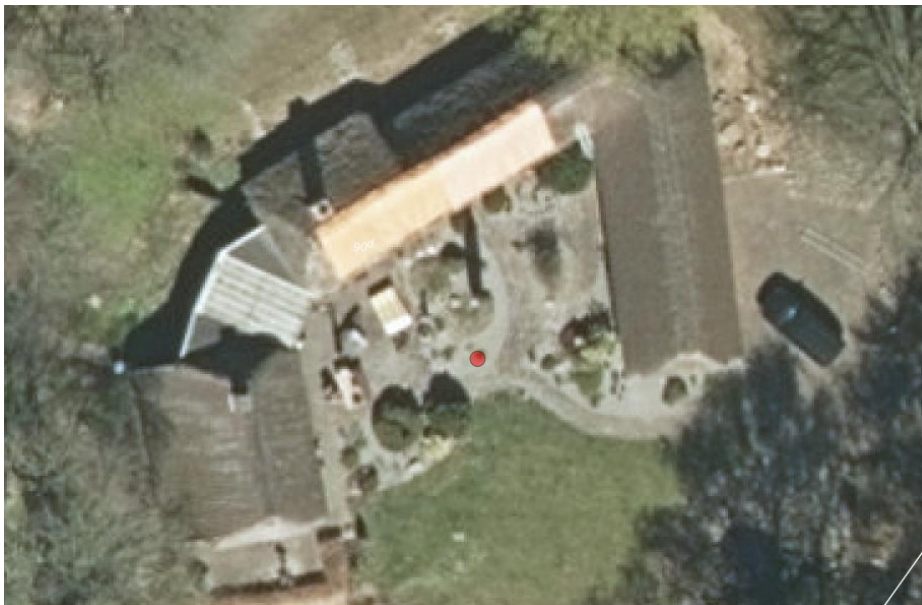
Ejendommens beboelsesbygninger set fra luften. Ansøgningen vedrører ændringer i taget på den midterste længe, der sammen med længen til højre udgør enfamiliehuset. Længen til venstre et anneks.
