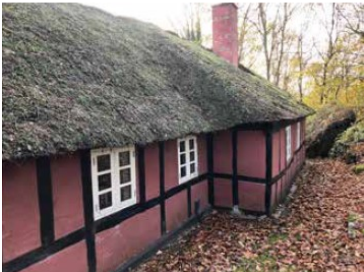
Tagudhænget på husets nordside. Indsat fra ansøgningsmaterialet.
