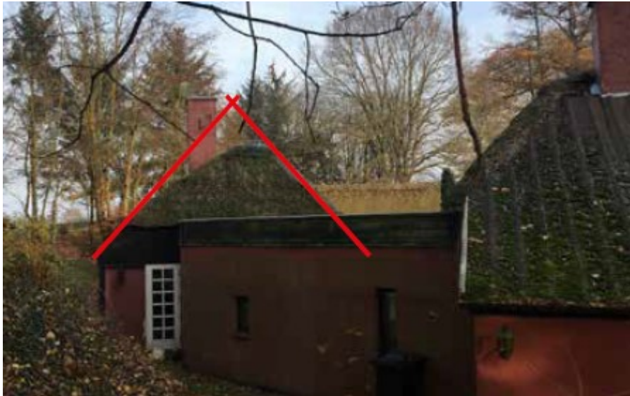
Billede af nuværende forhold set fra vest og illustration af profilen, som den vil se ud efter ombygningen. Indsat fra ansøgningsmaterialet.
