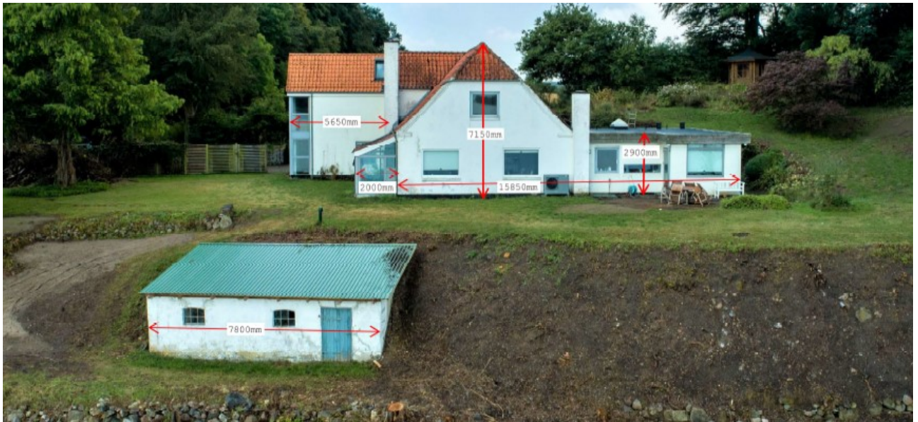
Medsendt foto af nuværende byggeri set direkte fra vandet, med angivelse af byggeriets størrelse
