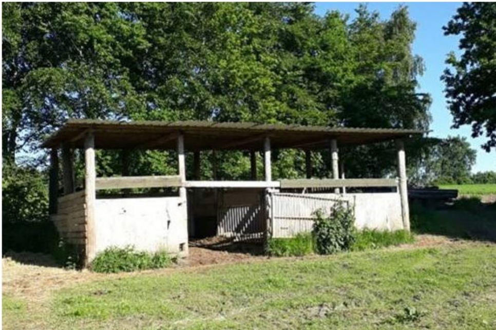
Foto fra forespørgslen, der viser læskurets udseende.
