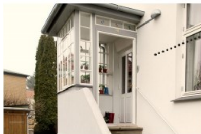
vindfang med gl vinduer og tagpap
