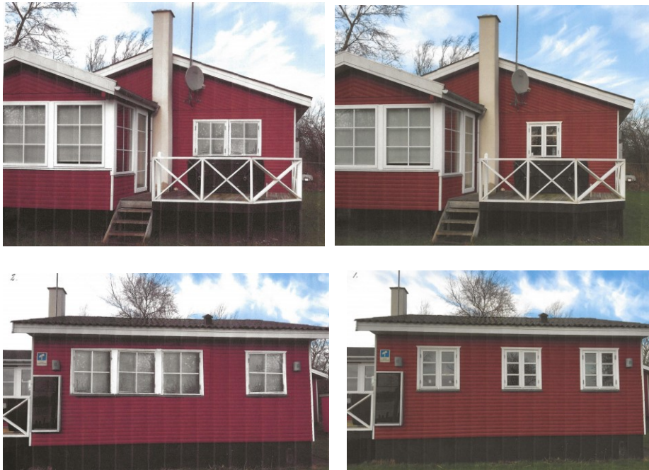
Facader efter ekstra vindue
