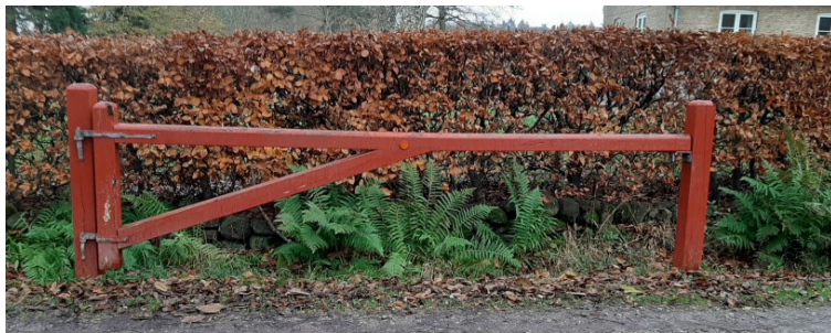
Fig. 6. Eksempel på bom, som i dette tilfælde ønskes i egetræ og ikke malet.
