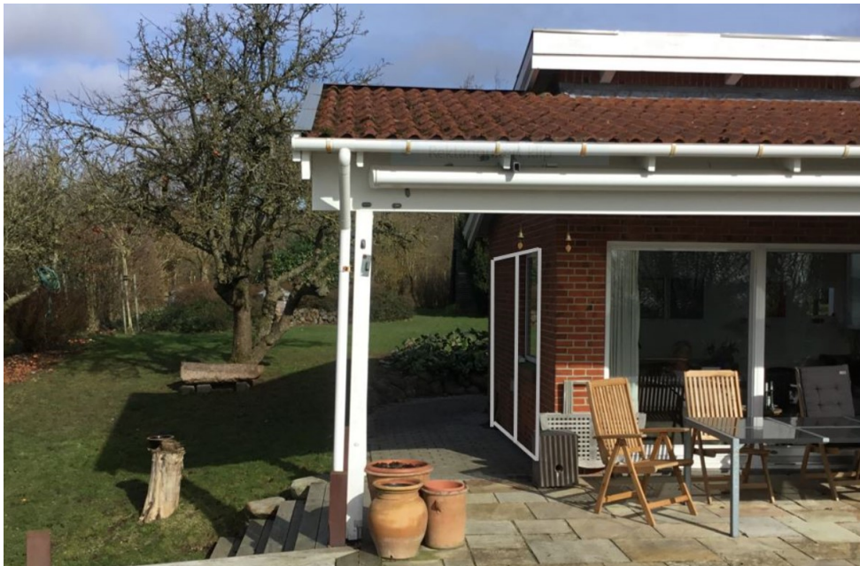
Skydedørspartiet markeret med hvide streger under halvtaget.
