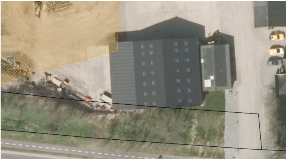
Luftfoto af bygningen. Det strandbeskyttede areal er markeret med orange skravering. Indsat fra SagsGIS.
