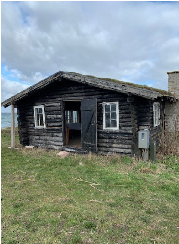
Billede fra besigtigelse. Adgangsdør og skorsten ses
