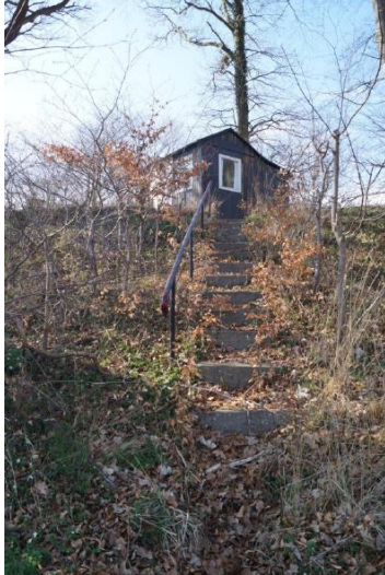
Foto fra besigtigelsen, der viser trappen.
