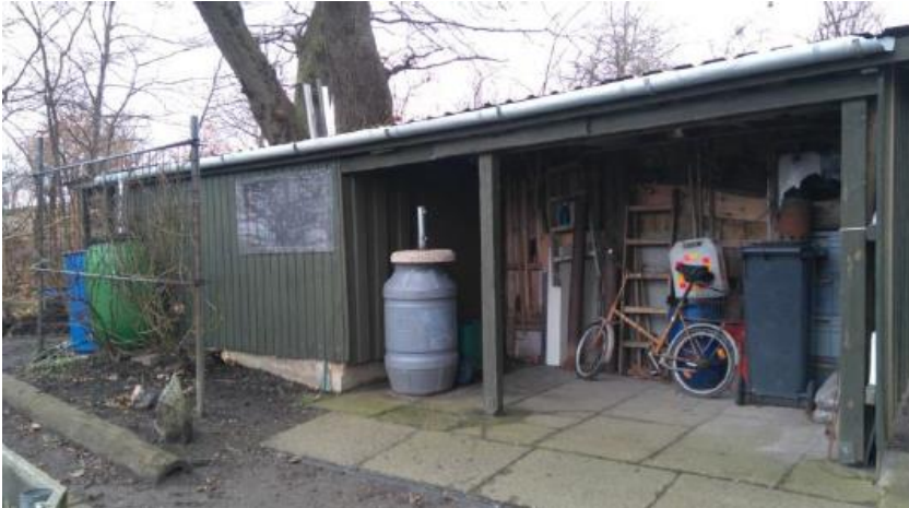
Foto fra besigtigelsen i 2017, der viser skuret set fra syd.
