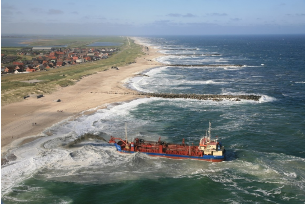
Kystnær fodring ved indpumpning af sand i en stråle ('Rainbow') fra sandsugeren
