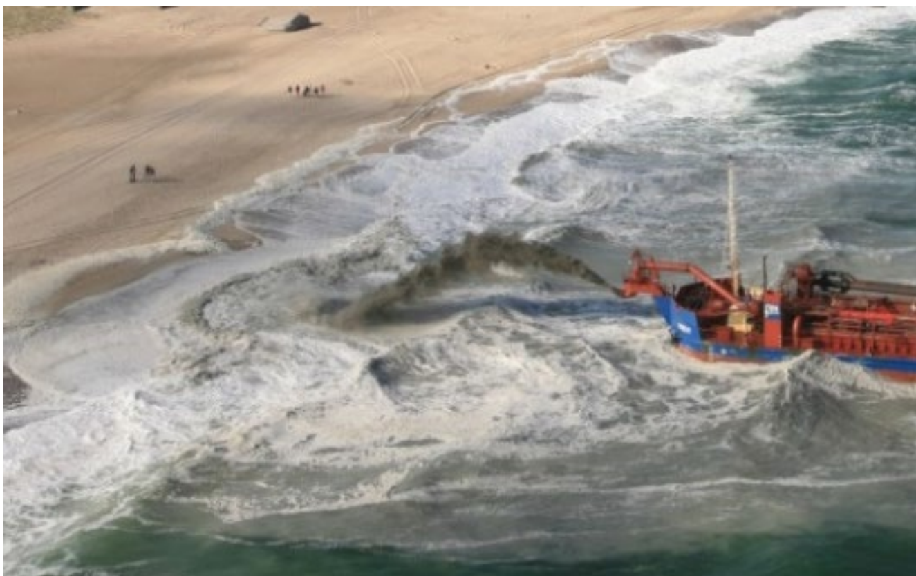
Kystnær fodring ved indpumpning af sand i en stråle ('Rainbow') fra sandsugeren
