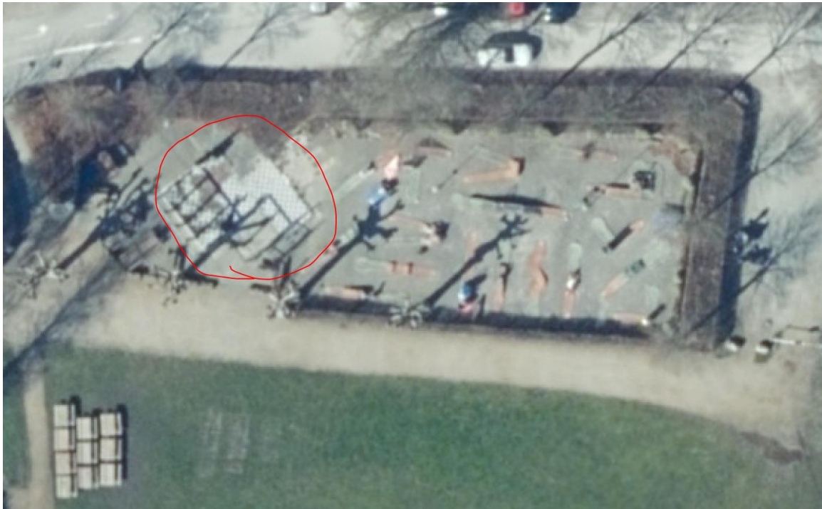
Foto af området efter branden. Den tilbageværende sokkel er markeret med rød.
