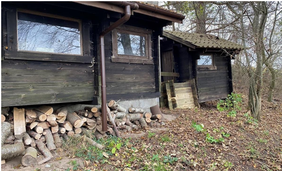
Fig. 3. Billede fra ansøgning. Viser vest-enden af hovedhuset og toilethuset, set fra nord.
