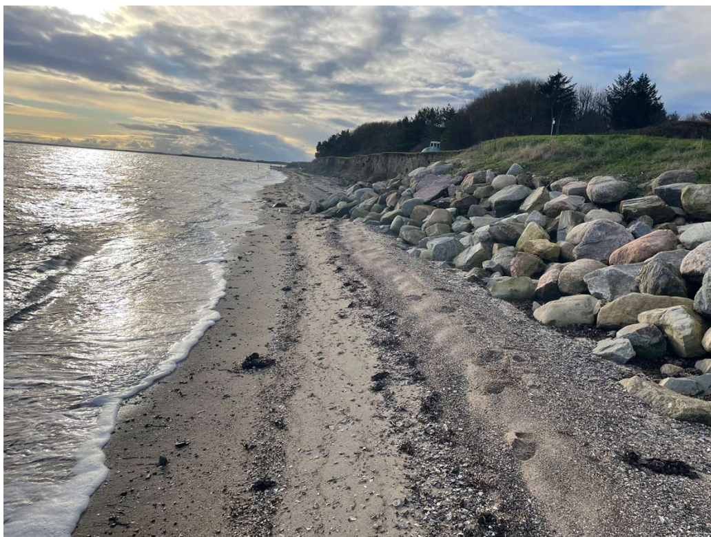
Figur 2. Besigtigelse den 20/11-2024. Projektet består i en forlængelse af eksisterende skråningsbeskyttelse på strækningen øverst i billedet, hvor kystskrænten er udsat for erosion. Projektet er placeret på stranden og på kystskrænten.
