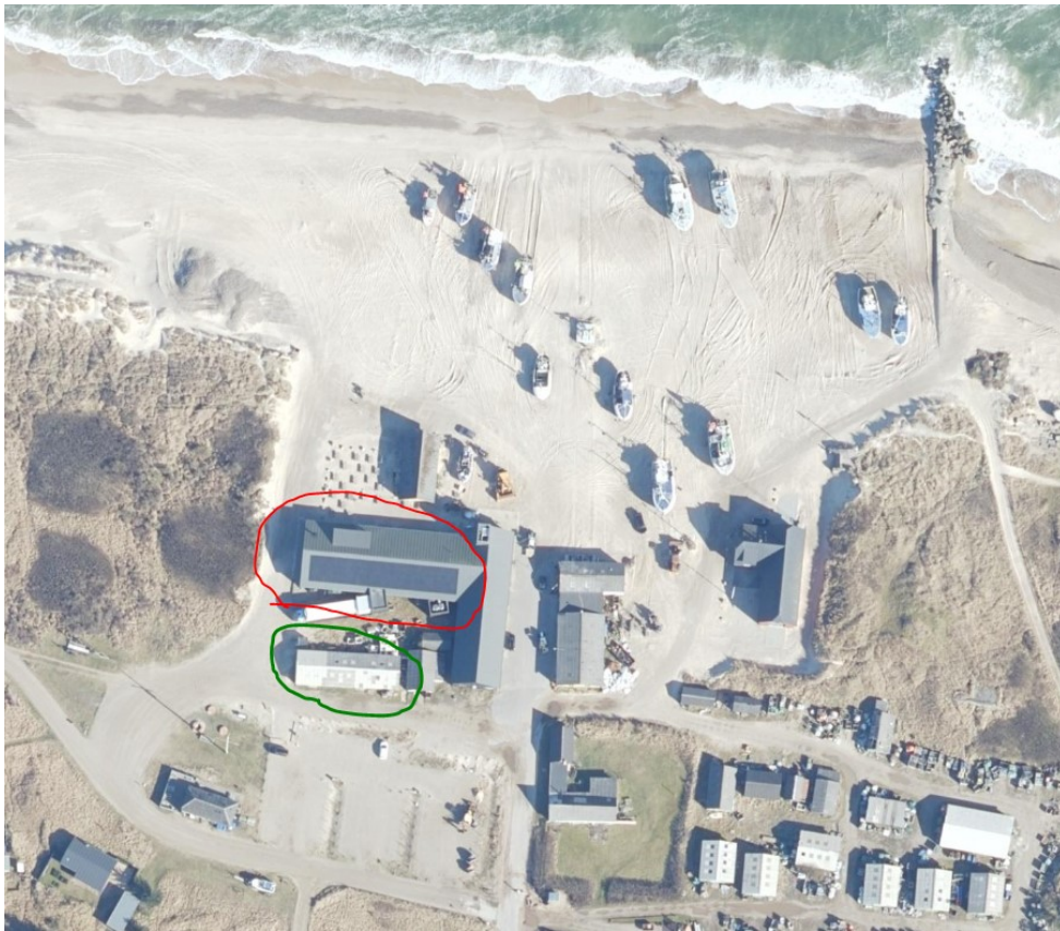
Luftfoto af området. Redskabsskuret, som skal anvendes til restaurant er markeret med grøn. Bygningen, der huser Thorupstrand Fiskehus, er markeret med rød. Syd for redskabsskuret ses parkeringspladsen.
