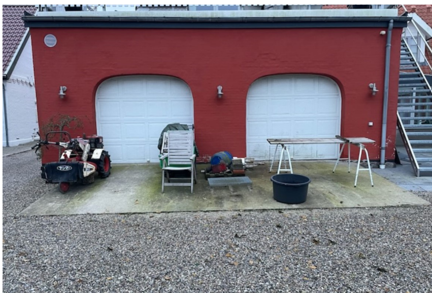
Figur 5, billede af garagen med det støbte dæk, hvor bygningen opføres. Fra ansøgningen.
