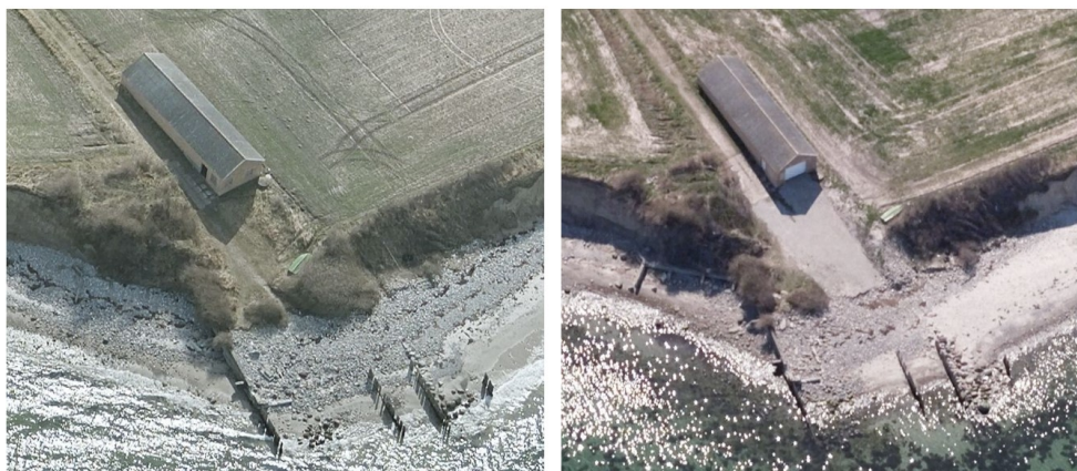
Figur 2. Skråfotos fra 2017 til venstre og fra 2019 til højre viser facadeændringen på bådhuset.
