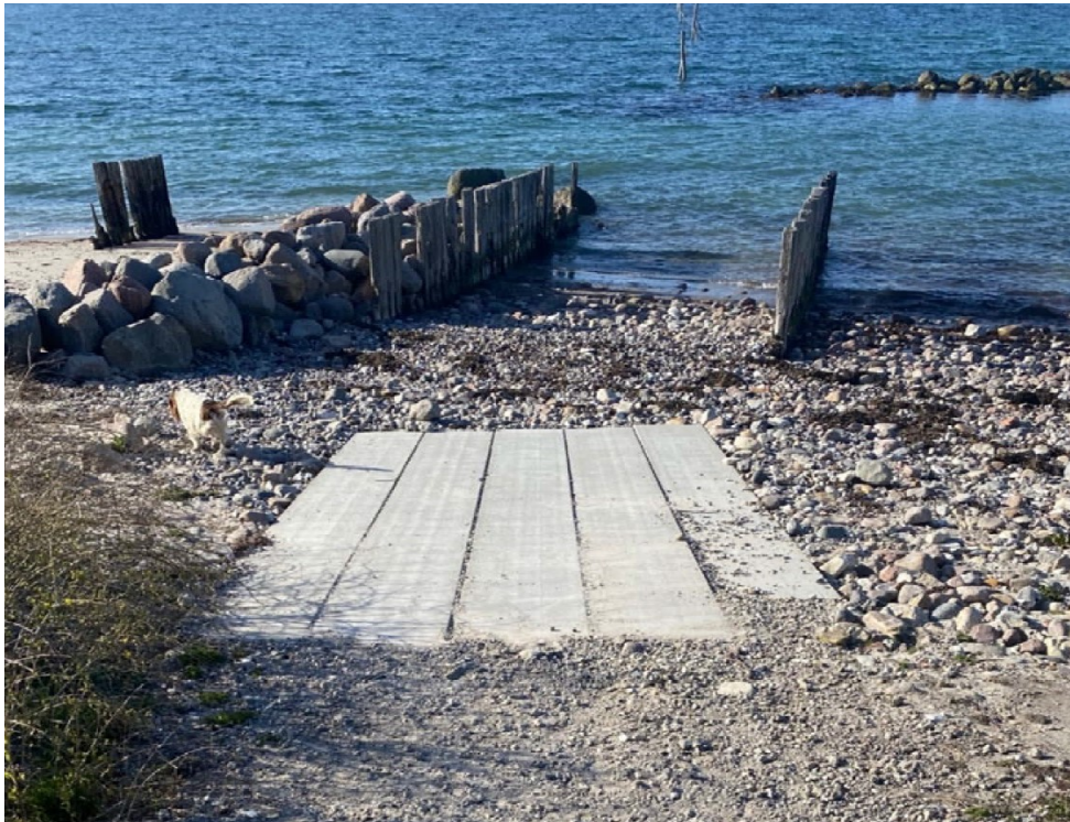
Figur 3. Foto fra ansøgningen viser fem betonpæle, der er lagt ned i sandet for at stabilisere slæbestedet.
