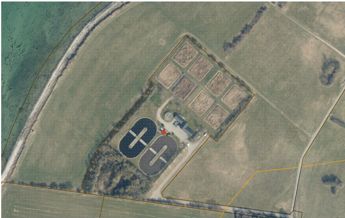
Luftfoto viser rensningsanlægget. Strandbeskyttelseslinjen ses som orange streg.
