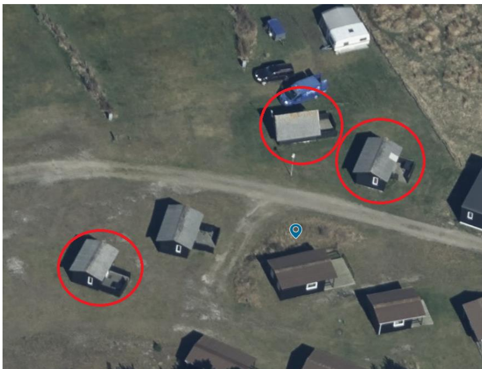
Fig. 6. Skråfoto d. 02-04-2023. På figuren er de campinghytter der ansøges udskiftet markeret med røde cirkler. På billedet ses campinghytternes sydvendte facade.
