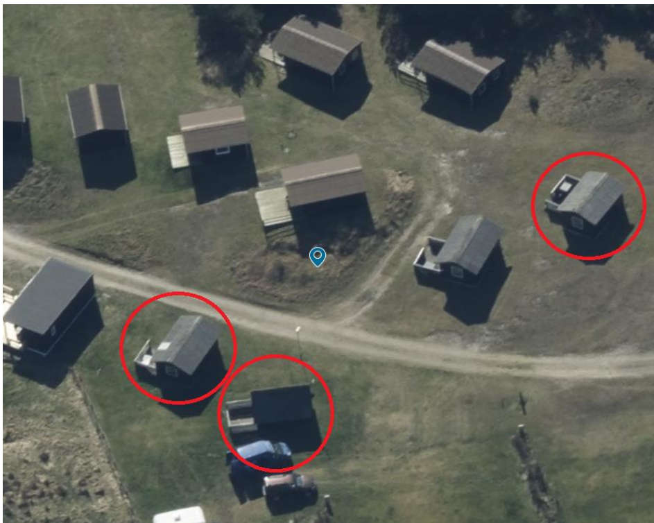
Fig. 5. Skråfoto d. 02-04-2023. På figuren er de campinghytter der ansøges udskiftet markeret med røde cirkler. På billedet ses campinghytternes nordvendte facade.
