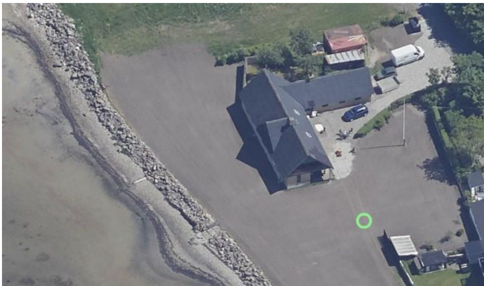
Ejendommen set fra nordvest
