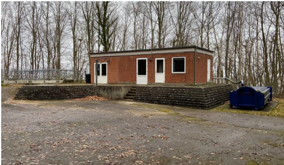
Foto af eksisterende pumpestation. Indsat fra ansøgningsmaterialet. Eksisterende pumpehus og støttemur nedrives, og terrænet udjævnes, hvorefter det tilsås med græs. Det nye pumpehus placeres dermed ca. 1 meter lavere end det eksisterende.
