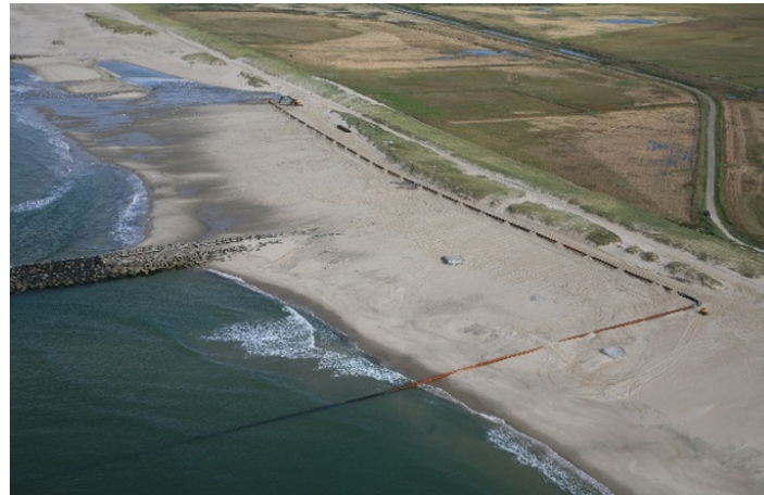
Indpumpning med bundliggende rørledning hvor sandet fordeles parallelt med stranden.
