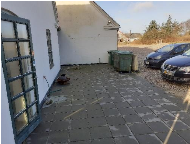
Fig. 2 viser et nærbillede af området af hovedbygningen, hvor der ønskes at opføre et udhus med overdækning.
