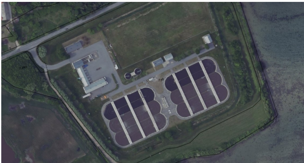
Luftfoto af Svendborg Centralrenseanlæg indsat fra SagsGIS. Renseanlægget er i sin helhed placeret inden for strandbeskyttelseslinjen.
