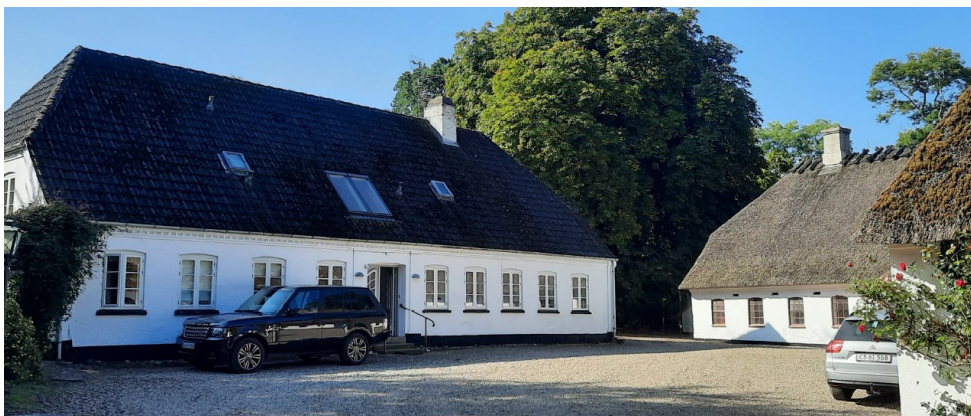
Foto af stuehuset set fra syd og gårdspladsen. Til højre i billedet ses en del af driftsbygningen (bygning 2). Nuværende forhold. Indsendt af ansøger.
