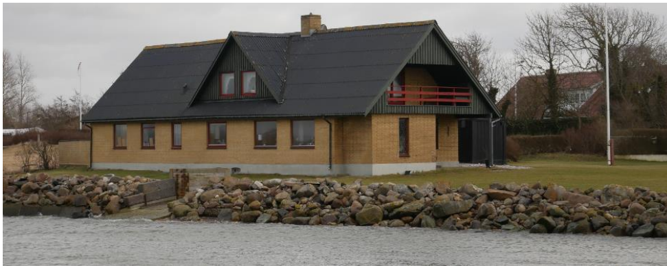
Eksisterende boligs facade mod vandet (nordfacaden)
