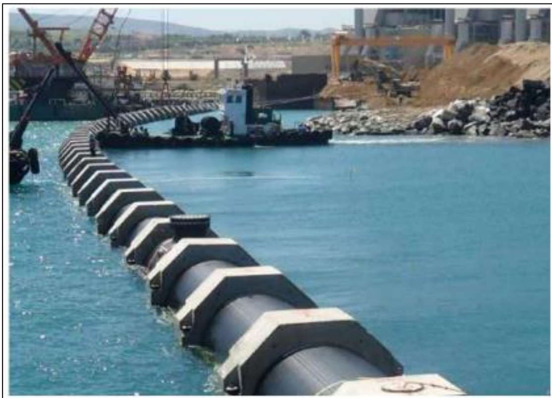
Figur 2-2 Eksempel på stor PEH-ledning med monterede ballastklodser. Kilde: Pipelife.com
