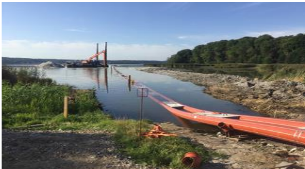
Figur 1-13 Udtrækning af ledning på vand, COWI, Mariagerfjord 2017.
