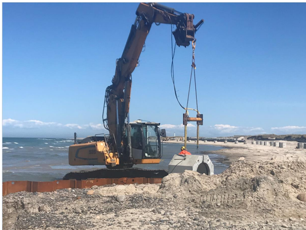
Figur 1-10 Ballastklods er ved at blive monteret på udløbsledning. COWI, Skagen maj 2020.
