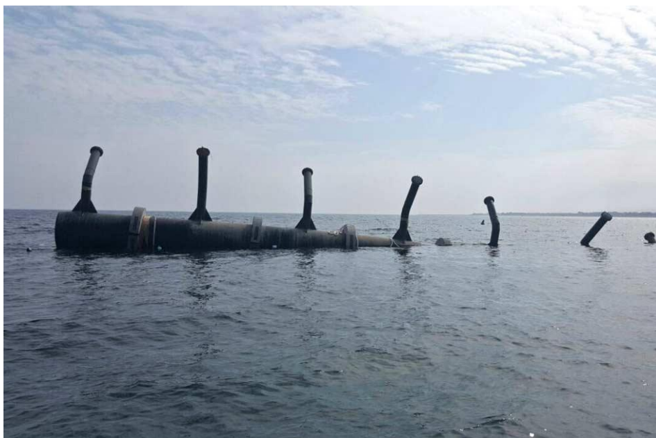
Figur 1-3 Eksempel på udløbsledning med diffusorporte under nedsækning på havbunden.
