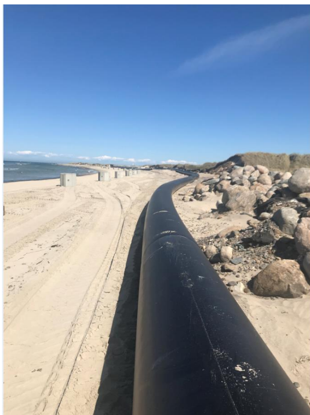
Figur 1-7 Svejst udløbsledning, COWI, Skagen maj 2020.
