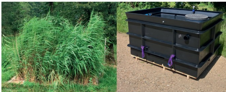
Filteranlæg beplantet og anlægget før nedgravning Under. Nedgravet og med jordvold
