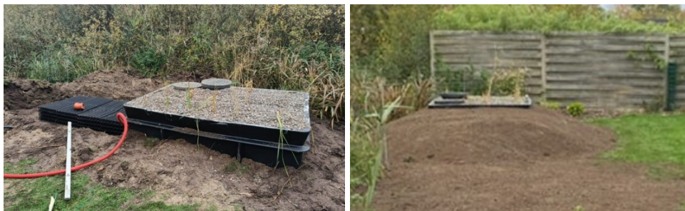
Filteranlæg beplantet og anlægget før nedgravning Under. Nedgravet og med jordvold
