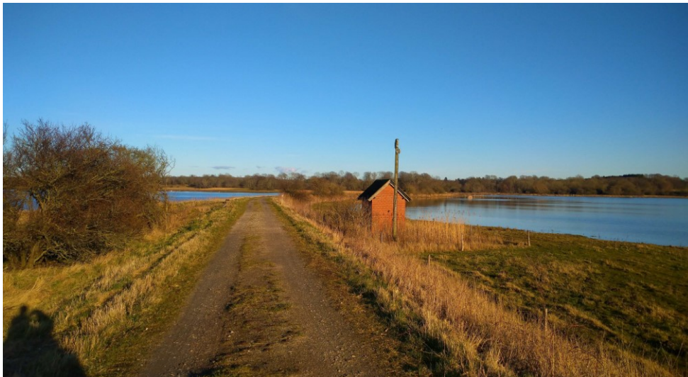
Foto af pumpehuset set fra vest.
