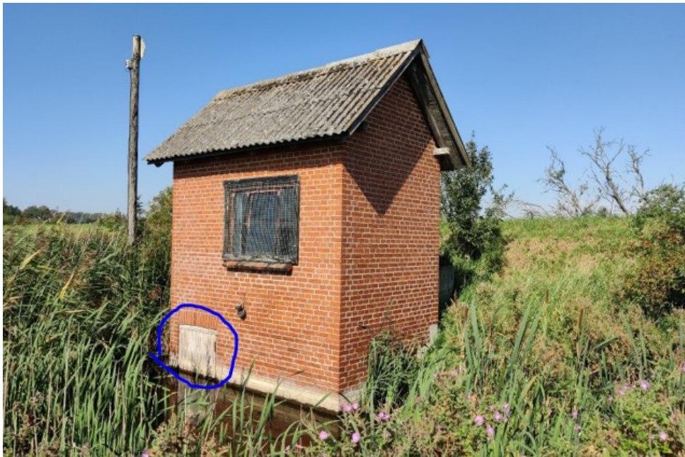
Foto af pumpehuset set fra syd. Solcellen placeres over den delvist oversvømmede dør (markeret med blå).
