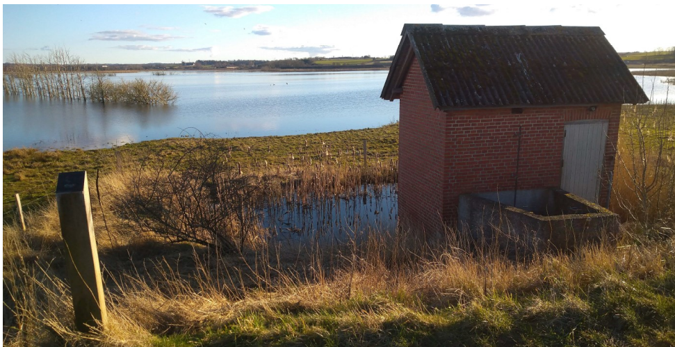
Foto af pumpehuset set fra nord. Udløbingsbassinet, der overdækkes med jerngitter ses foran bygningen.
