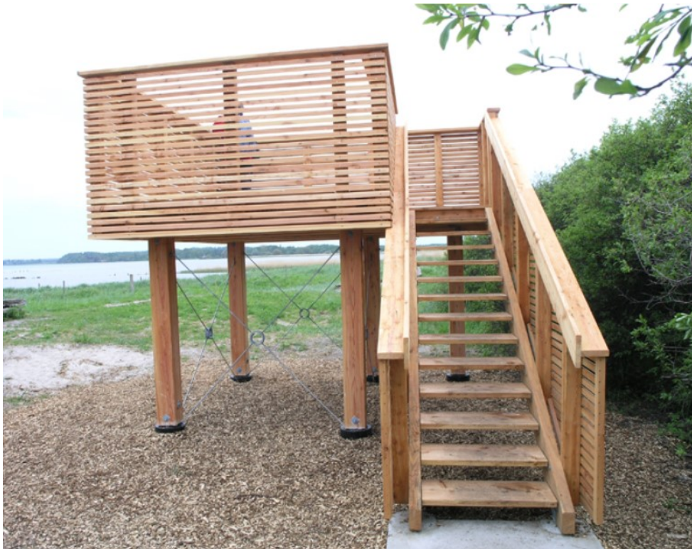
Tårnets dimensioner bliver 6,2m i højden og 3,5m x 4,2m flade og med en 1 x 7 trappe til. Tårnet vil fremstå i træets naturlige farve.
