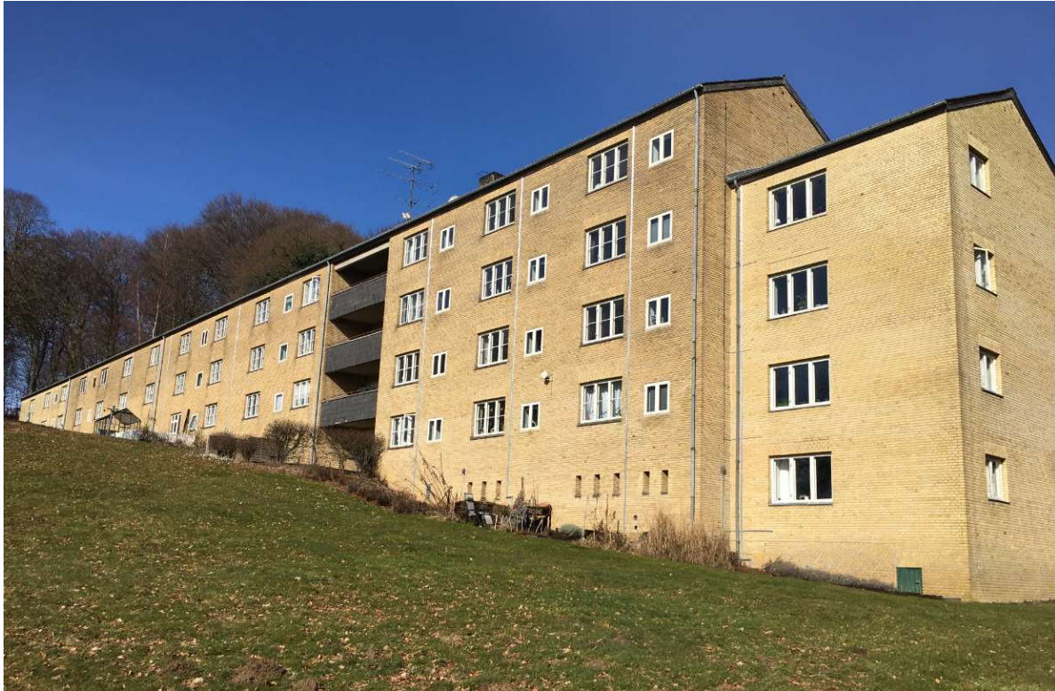
Medsendt foto af ejendommen, set fra vandsiden
