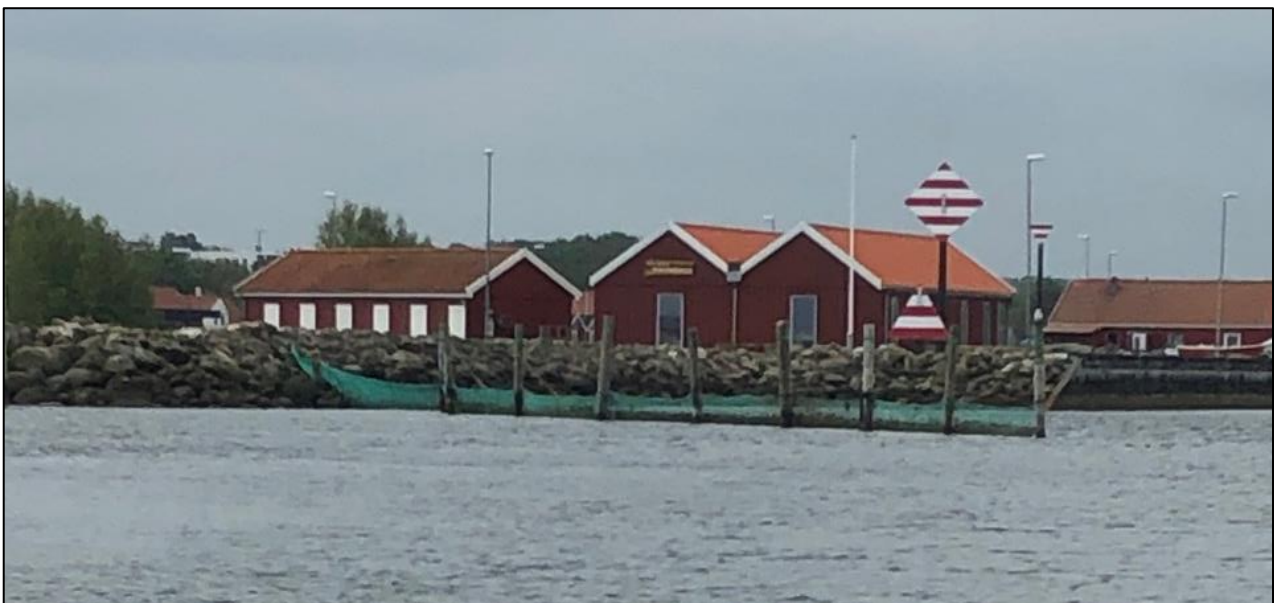
Figur 3 Anlæg set fra havsiden
