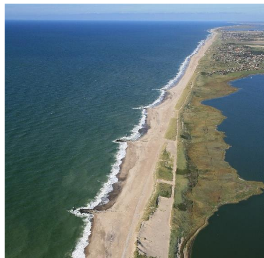
Det smalle klitlandskab set fra syd. I forgrunden ses den smalle tange mellem Vesterhavet og Ferring Sø, der er sikret ved høfder, skråningsbeskyttelse og diger 47 .
