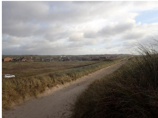
Det lavtliggende sommerhusområde Ferring Strand set mod syd fra rekreativ sti på kystbeskyttelsesdiget.
