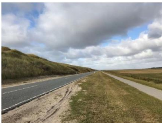
Overgangen mellem diget (tv.), landevejen og strandengene set mod nord.
