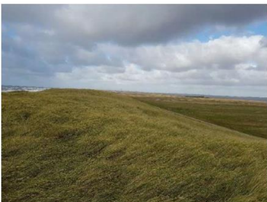
Toppen af diget mellem kysten og strandengene. Landevej 181 forløber ved foden af diget.
