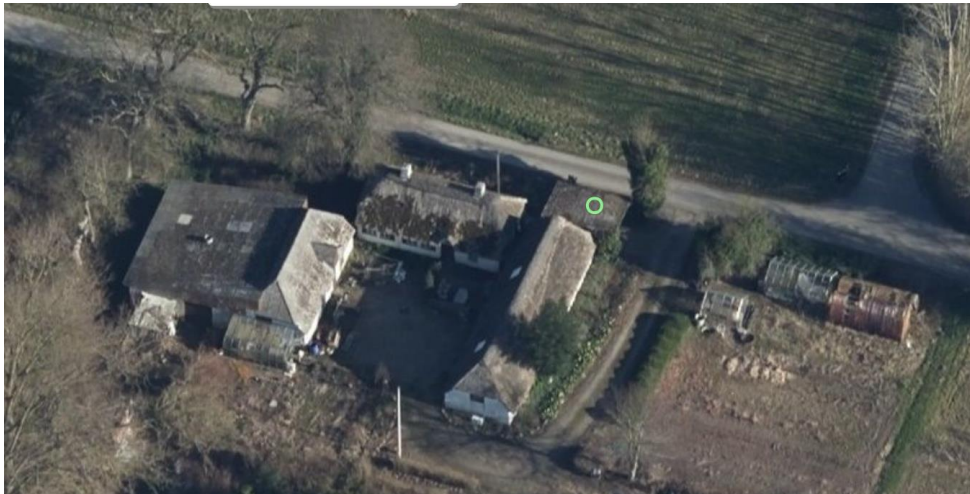
Eksisterende bebyggelse – stuehuset ligger op mod vejen
