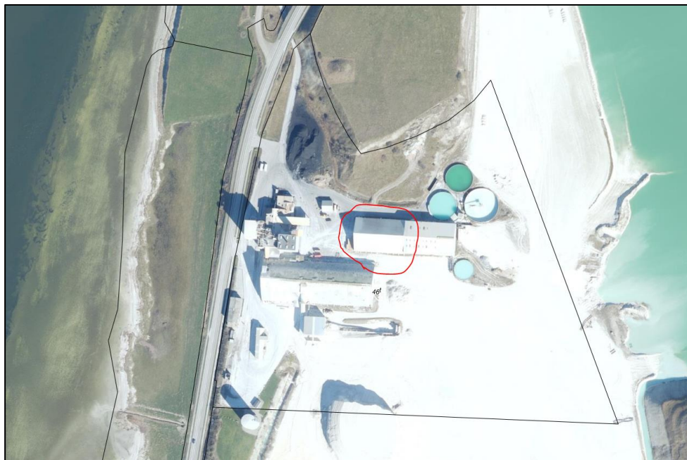
Luftfoto af kalkværkets bygninger. Den nu sammenstyrtede bygning er markeret med rød.
