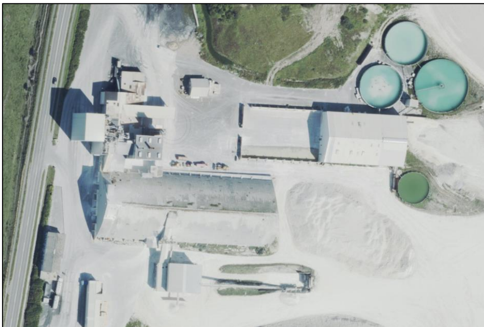
Foto taget efter bygningen styrtede sammen.
