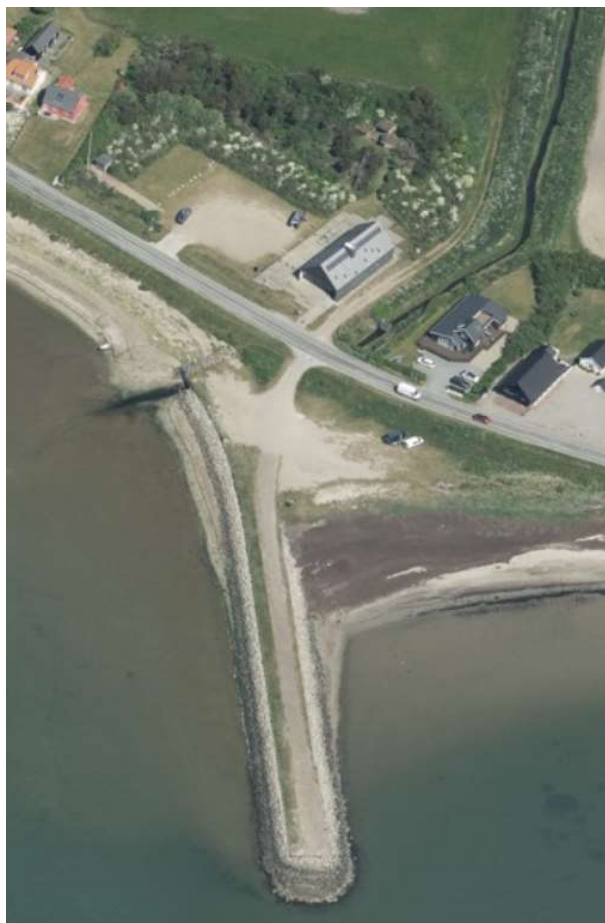
Figur 2. Skråfoto fra 1. juni 2023 over området. Molen ses i bunden af billedet. I midten af billedet forløber Krik Strandvej på tværs der adskiller molen fra Kulhuset og parkeringspladsen. Øverst i billedet fremgår inden for strandbeskyttelseslinjen
